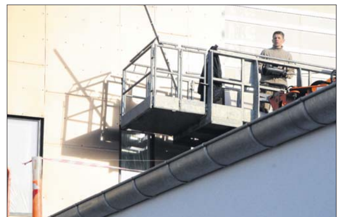
Der sættes i alt 1200 kvadratmeter kobberfarvet facade op på det nye rådhus.
